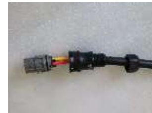
Ilustración 4.16 Conectar los cables al borne
